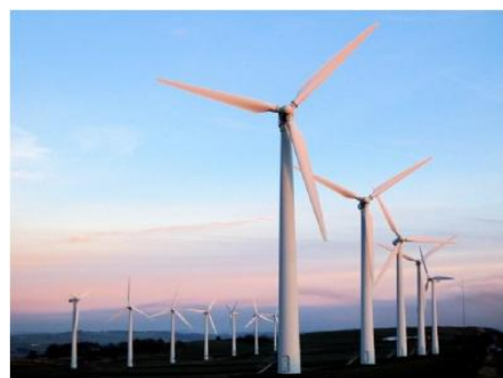
Fig: wind turbine
